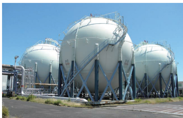
LPGタンク支持構造強靱化 (徳山事業所)
